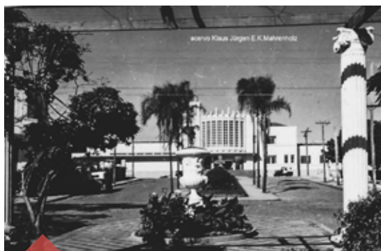
Figura 18: Edifício da Estação visto da Av. Washington Luís, 1950. Fonte: Museu e Arquivo Histórico Municipal.
