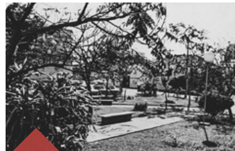
Figura 87: Mobiliário da Praça Nossa Senhora Aparecida antes da reforma. Fonte: http://www.presidenteprudente.sp.gov.br/site/noticias.AAaxhtml?cod=22350 Acesso em 20/11/2017.
