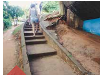
Figura 116: Escada de concreto de acesso à Rua do Viaduto. Fonte: acervo pessoal, 2017.
