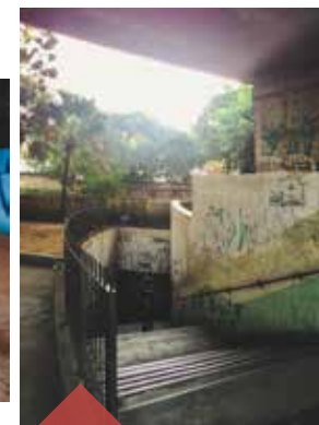
Figura 115: Saída do Túnel de pedestres. Fonte: acervo pessoal, 2017.
