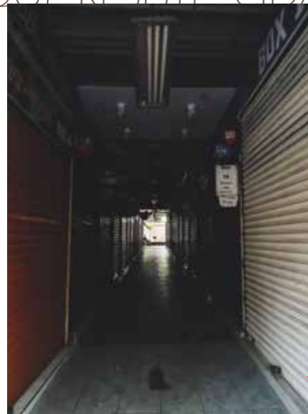
Figura 123: Corredor formado pelos boxes voltados para o interior do pavilhão. Fonte: acervo pessoal, 2017.
