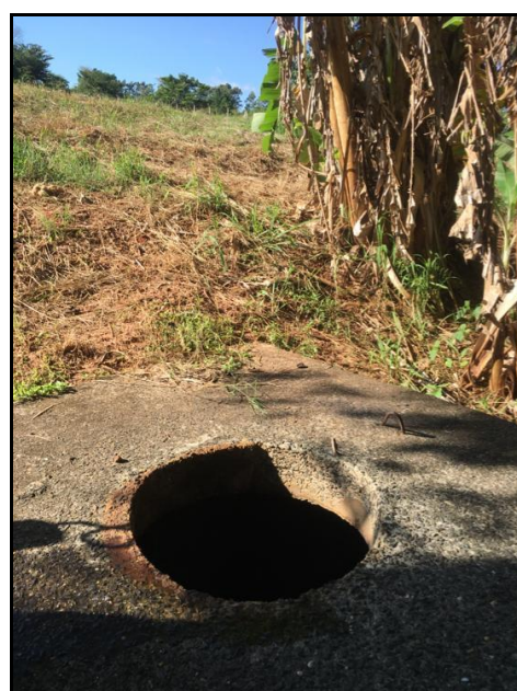
Figura 4.14. Ponto de coleta do efluente tratado (P9) da Estação de tratamento de Esgoto de Tibiriçá.
