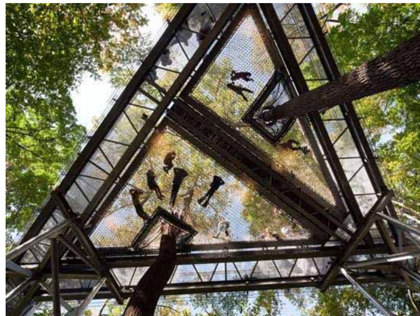
PLATAFORMA SUSPENSA NA FILADÉLFIA-EUA – VISTA INFERIOR
