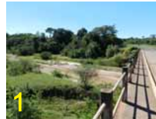
Detalhe da ponte sobre o córrego da onça. Foto: Marina Mello Vasconcellos
