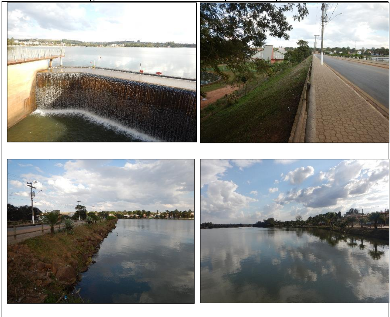
Figura 22. Levantamento de Campo na Barragem 64.
