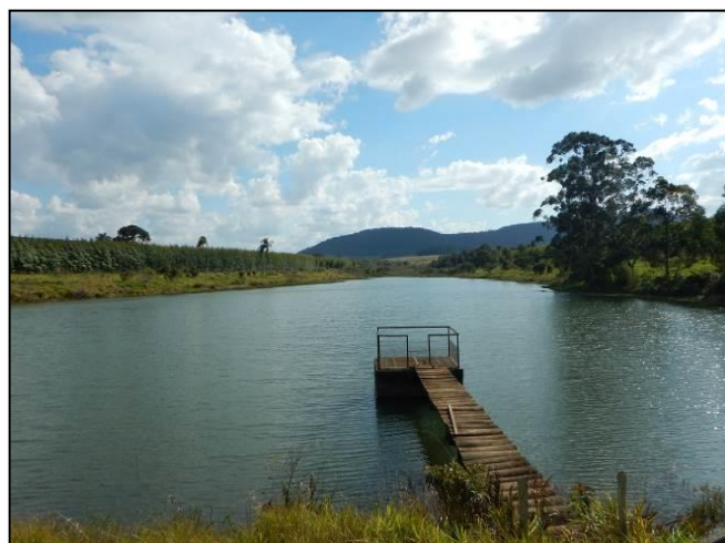
Foto 43. Reservatório com vertedouro de topo em bom estado.
