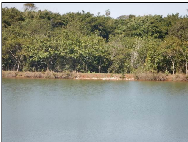
Foto 8. Evidência de que possivelmente já houve rompimento no reservatório.
