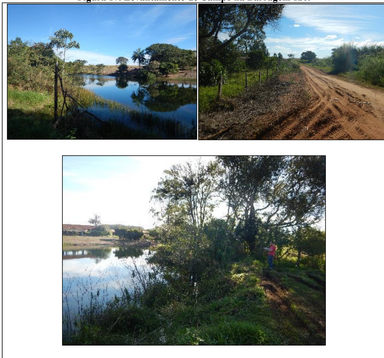
Figura 17. Levantamento de Campo na Barragem 120.
