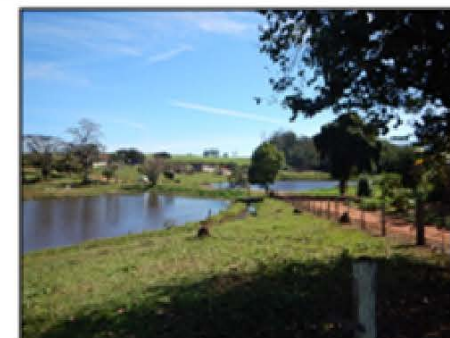
Maciço em bom estado de conservação
