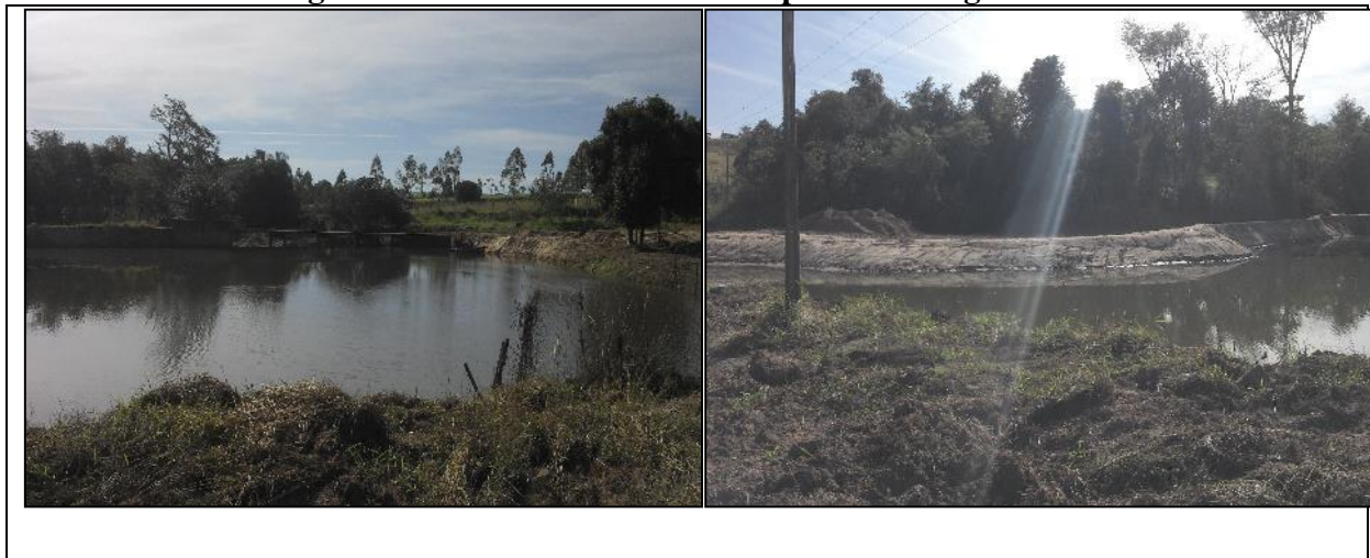
Figura 21. Levantamento de Campo na Barragem 129.
