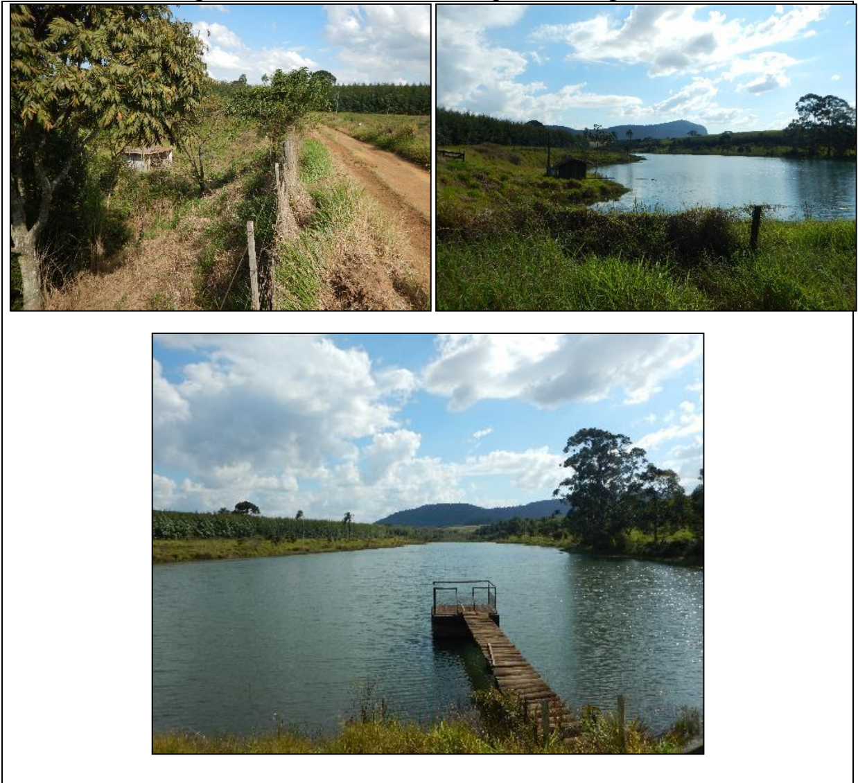
Figura 15. Levantamento de Campo na Barragem 98.
