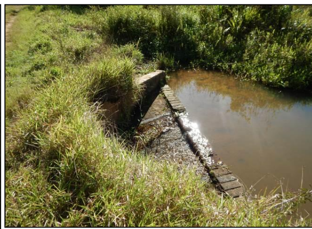
Foto 8. Vertedouro de topo lateral montante em bom estado.
