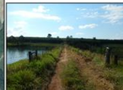
Maciço com falta de manutenção
