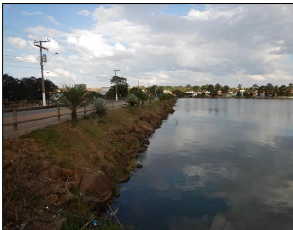
Foto 51. Enrocamento construído no reservatório funcionando como proteção contra a erosão das ondas.
