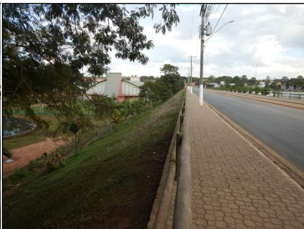
Foto 52. Talude a jusante do reservatório, apresentando boa conservação.
