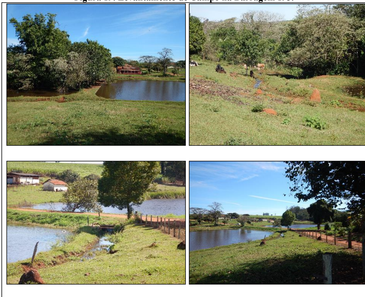
Figura 19. Levantamento de Campo na Barragem 193.
