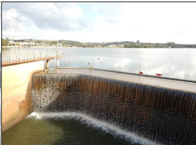
Foto 50. Vertedouro de topo lateral em bom estado.
