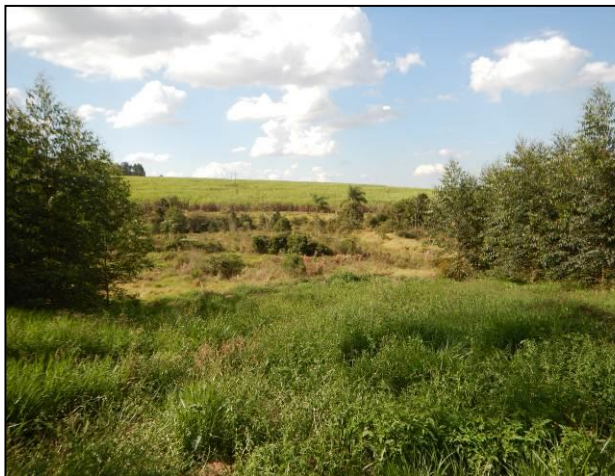
Foto 45. Vista do entorno da barragem que foi rompida com erosão leve.
