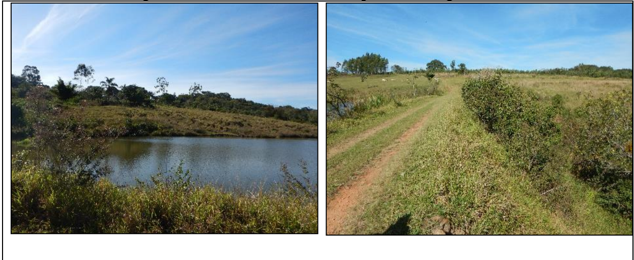
Figura 23. Levantamento de Campo na Barragem 133.
