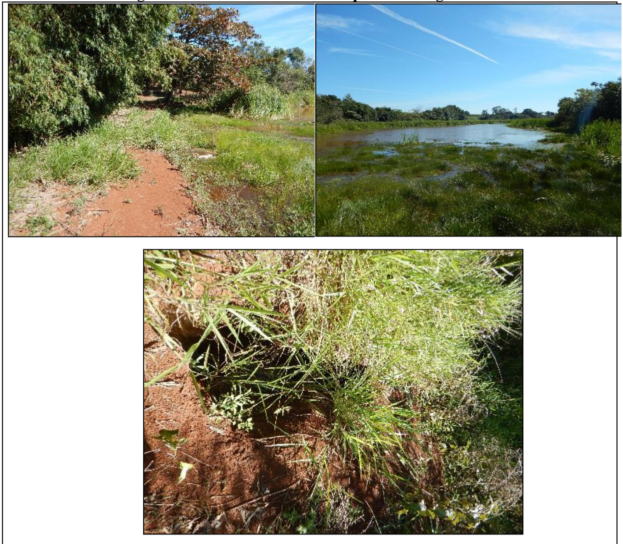
Figura 20. Levantamento de Campo na Barragem 222.
