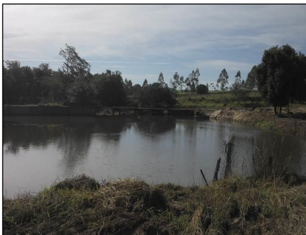
Foto 3. Vista do reservatório, com vertedouro de topo em bom estado de conservação
