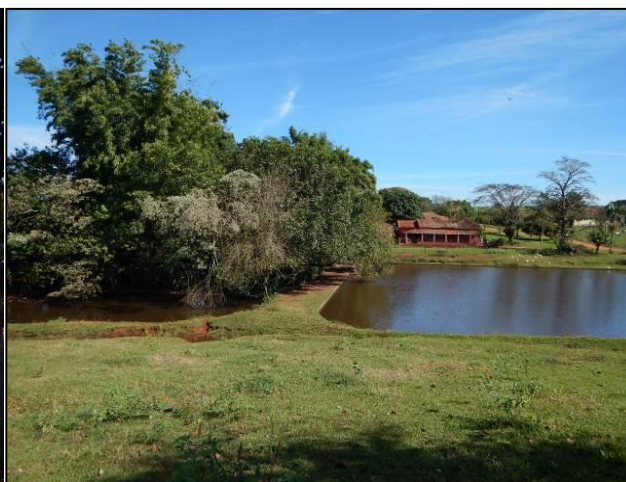
Foto 13. Maciço da segunda barragem e construções rurais no entorno.
