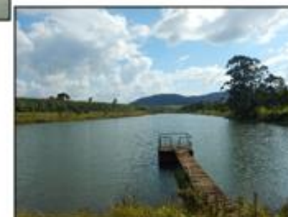
Vertedouro de topo em bom estado
