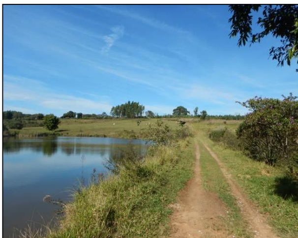
Foto 5. Vista do maciço em bom estado e reservatório à esquerda.
