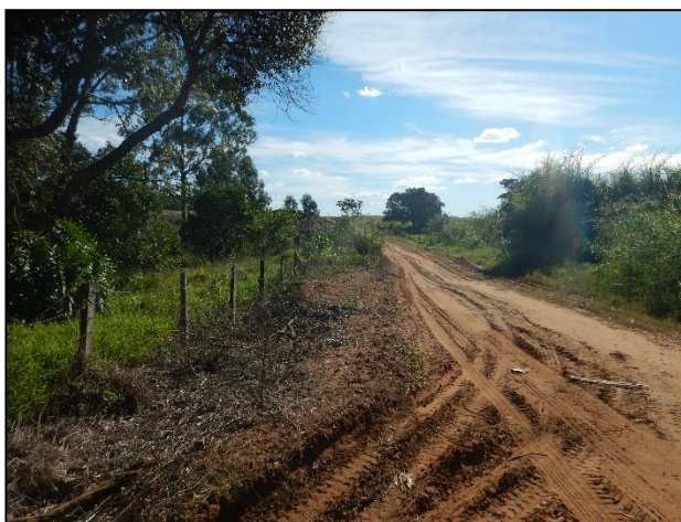
Foto 37. Maciço que foi aumentado devido à construção de uma estrada.
