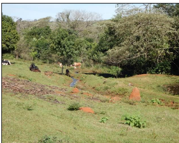
Foto 16. Processos de erosão ao final do vertedouro.
