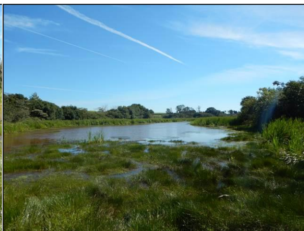
Foto 19. Reservatório com assoreamento intenso. presença de vegetação.
