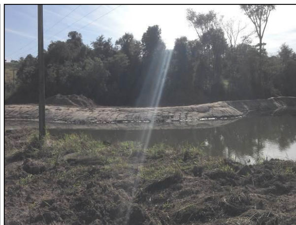
Foto 2. Vista de uma parte do reservatório.
