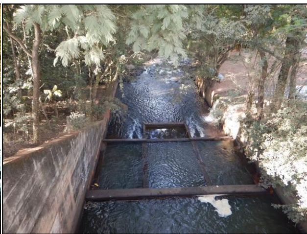
Foto 54. Obra de engenharia a jusante do reservatório.
