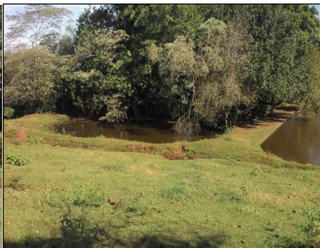
Foto 17. Talude a jusante da segunda barragem, com vegetação de grande porte.
