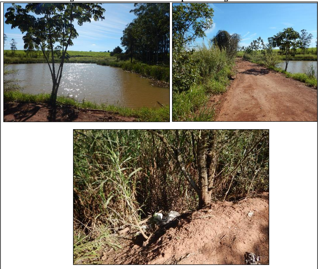
Figura 25. Levantamento de Campo na Barragem 244.
