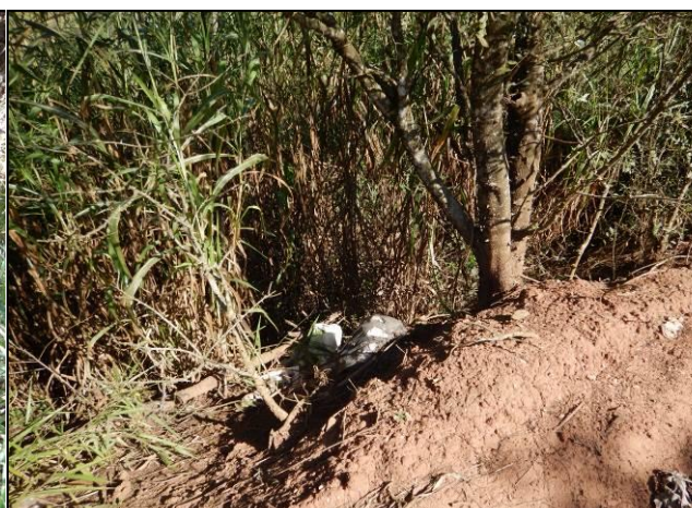
Foto 29. Talude apresentando alta declividade e erosão.
