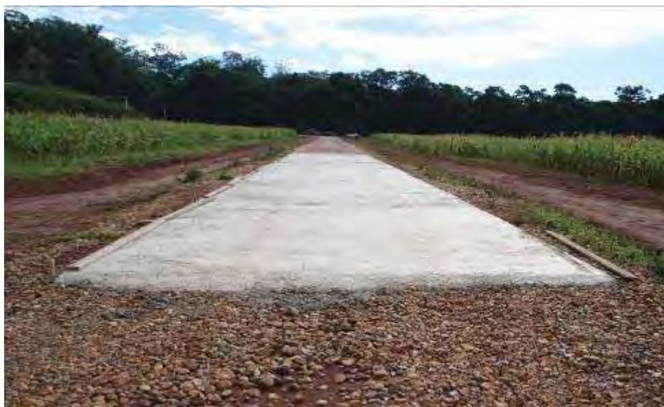
Figura 3 – Vista da pista de Concreto.
