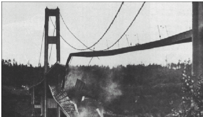
Figura 1.1 – Exemplo de ressonância induzida pelo vento (Pte Tacoma Narrows)
