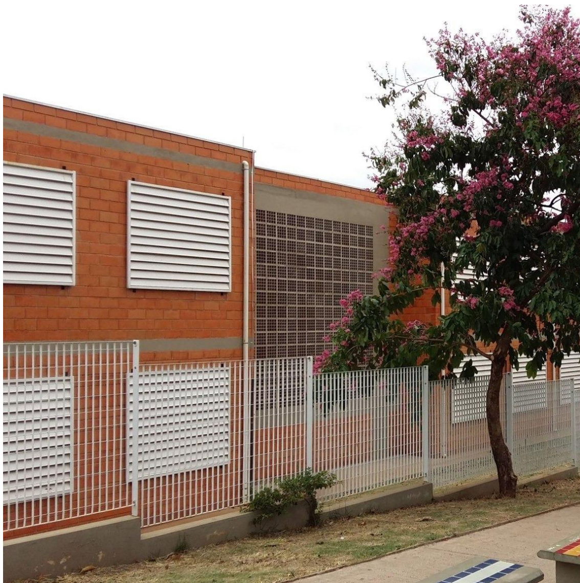
Figura 11 – Fachada da escola
