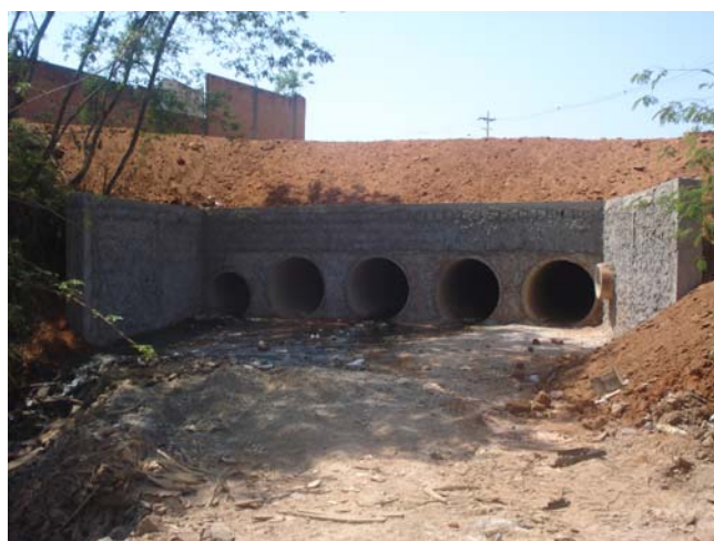
8 – Canalização córrego Olinda (obras recentes)
