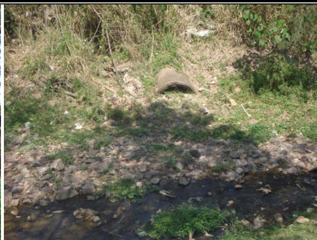
6 – Rede de drenagem urbana soterrada
