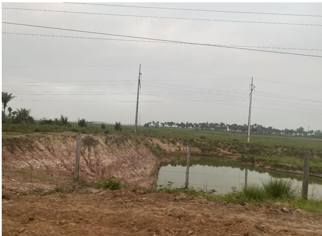
Figura 16. Processo erosivo as margens do rio da Bacia do Pindaré– MA
