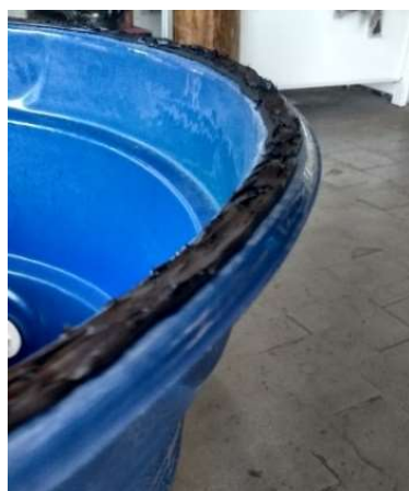
Figura 12 - Borda da caixa d'água com o adesivo selante aplicado.
