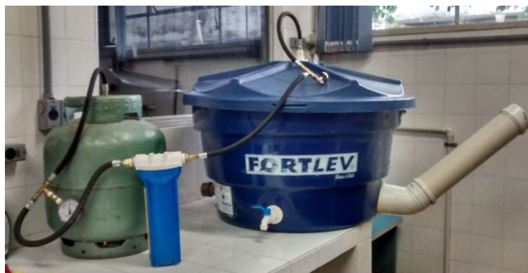
Figura 14 - Sistema do biodigestor construído com caixa d'água de 150 litros.
