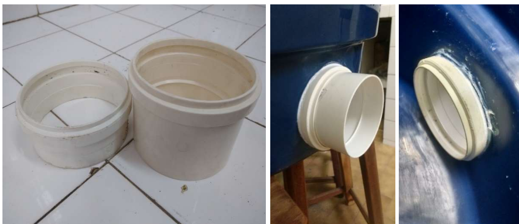
Figura 10 - Luvas de 100 mm cortadas (à esquerda) para a conexão do tubo de alimentação à caixa d'água, parte externa (centro) e detalhe da vedação interna em silicone (à direita).
