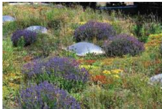
Figura 4 - Telhado verde semi-intensivo. Fonte: http://www.igraworld.com/types_of_green_roofs/index.php
