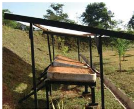
Figura 11 - Vista Lateral dos módulos-pilotos de telhado verde
