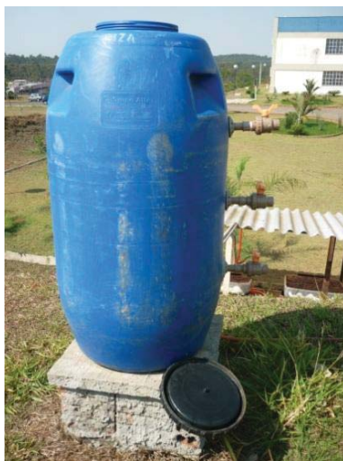
Figura 12 - Reservatório de 200L
