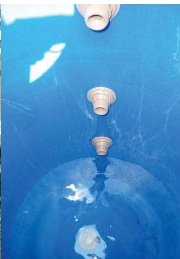
Figura 13 - Detalhe dentro do reservatório
