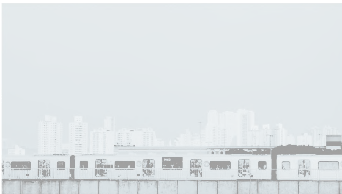
Imagem 10 - elevado do metrô na rodoviária Tietê
