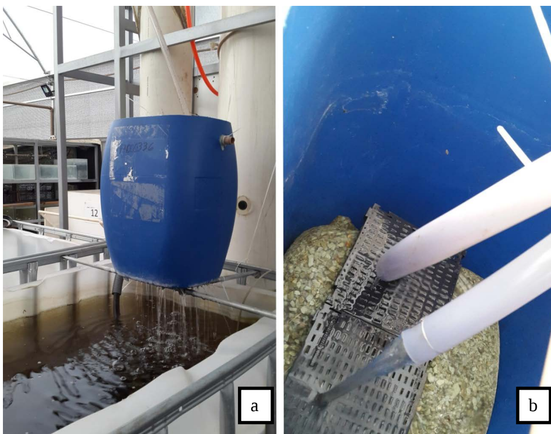
Figura 43 - Filtro com pedra zeolita, vista externa (a) e interna (b)
