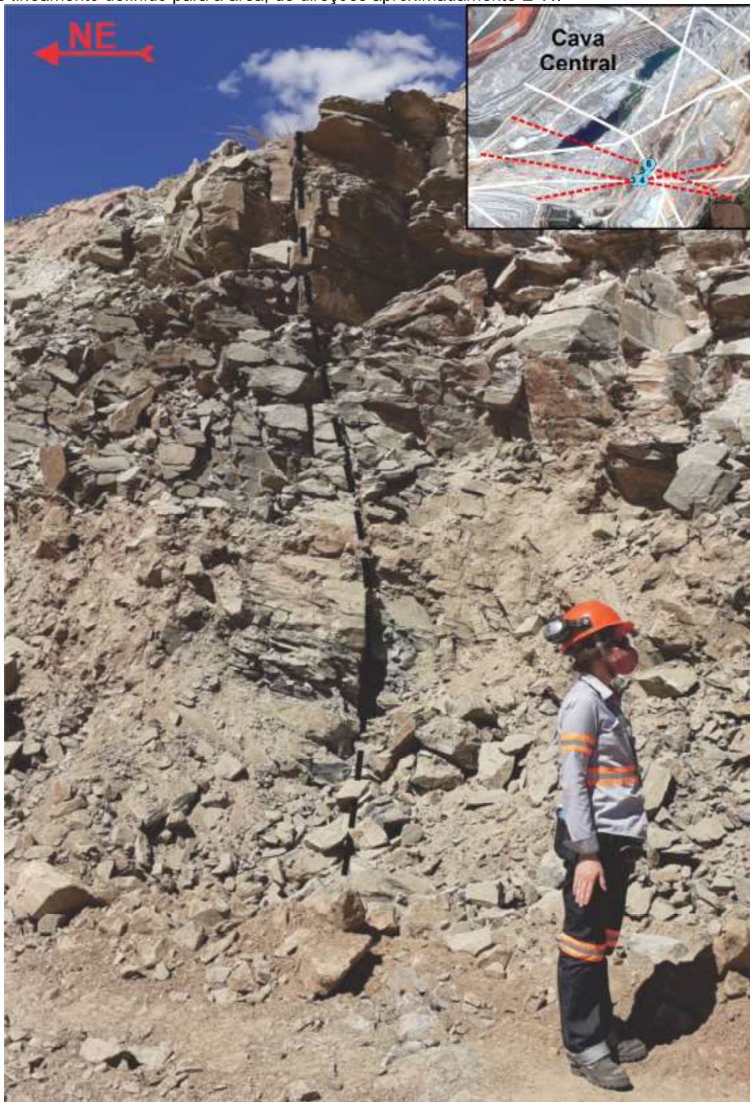
Figura 6.11 – Estrutura mensurada no ponto 3 da Cava Central (S80W/70NW). A região é mais fraturada que o entorno e a estrutura é marcada por feições planares subverticais. A estrutura medida está de acordo com o lineamento definido para a área, de direções aproximadamente E-W.
