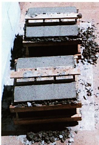
Fig.10 - Término da concretagem
