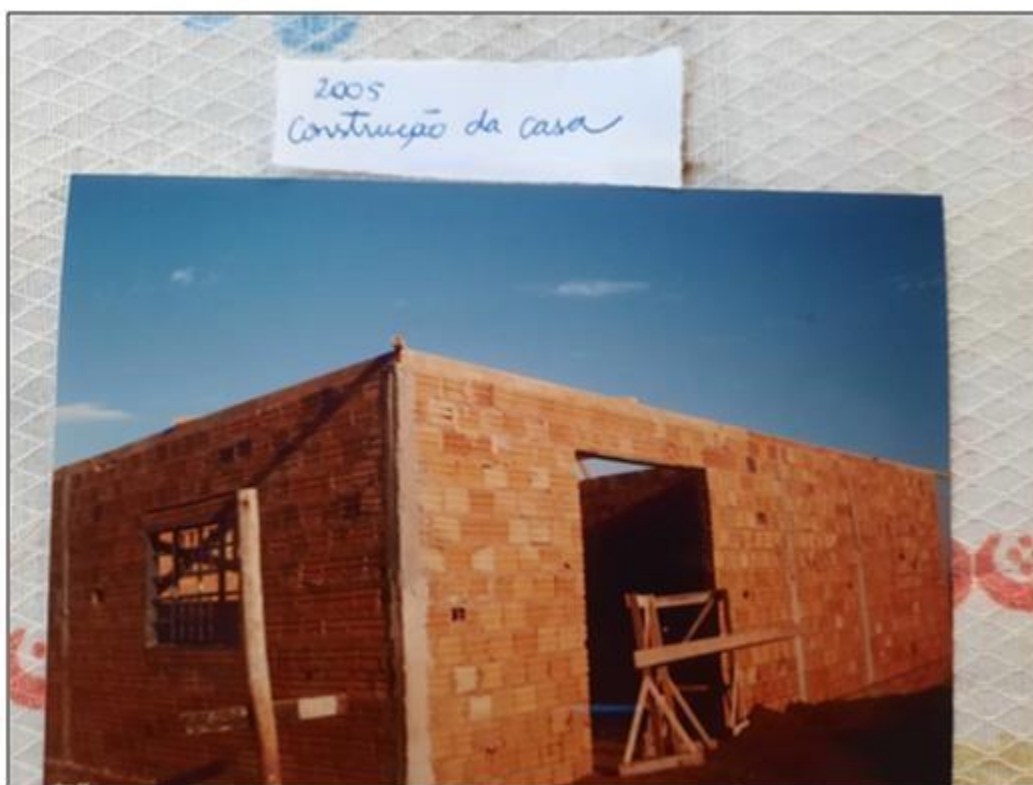
Figura 27 - 2005: Construção da casa
