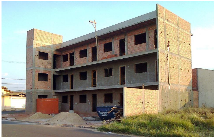
Imagem 2. Prédio de quintinetes em construção. Assis/SP, 2015, acervo pessoal
