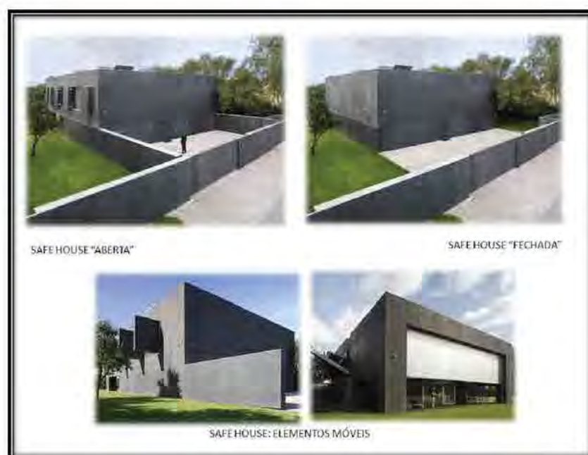
Imagem 33: Imagens da Safe House: quando está aberta, fechada e se movimentando.
