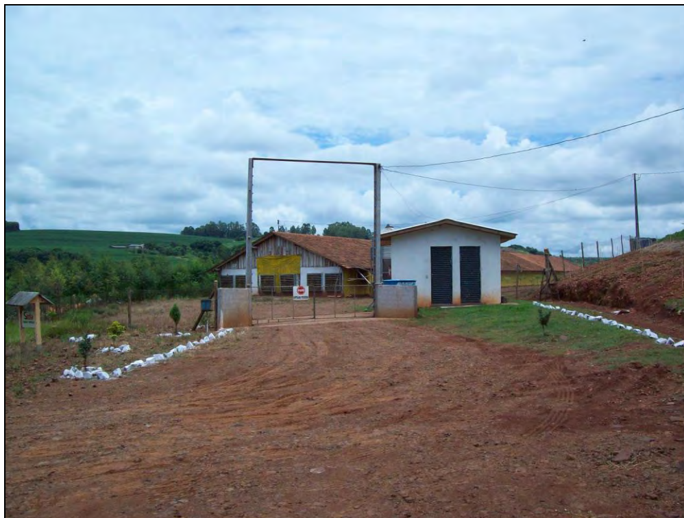
Foto 08 – Arco de desinfecção instalado na entrada de uma granja integrada à Sadia. Localização: proximidade de Vera Cruz do Oeste.
