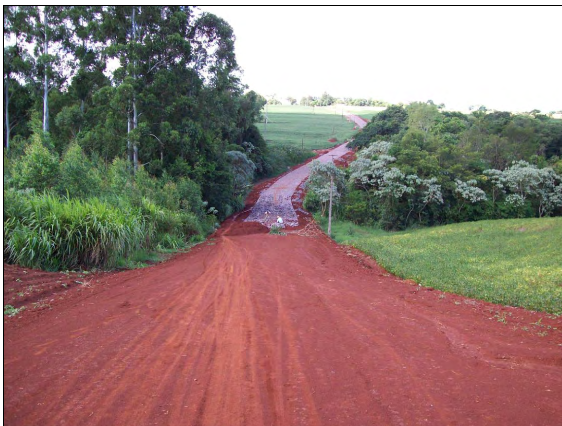
Foto 01 – Calçamento de estrada rural no município de Cafelândia – PR. FONTE: Trabalho de campo, 2009.
