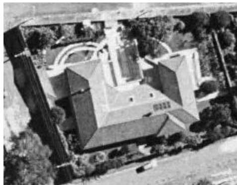
Figura 4.22 – Edificação com estrutura complexa.
