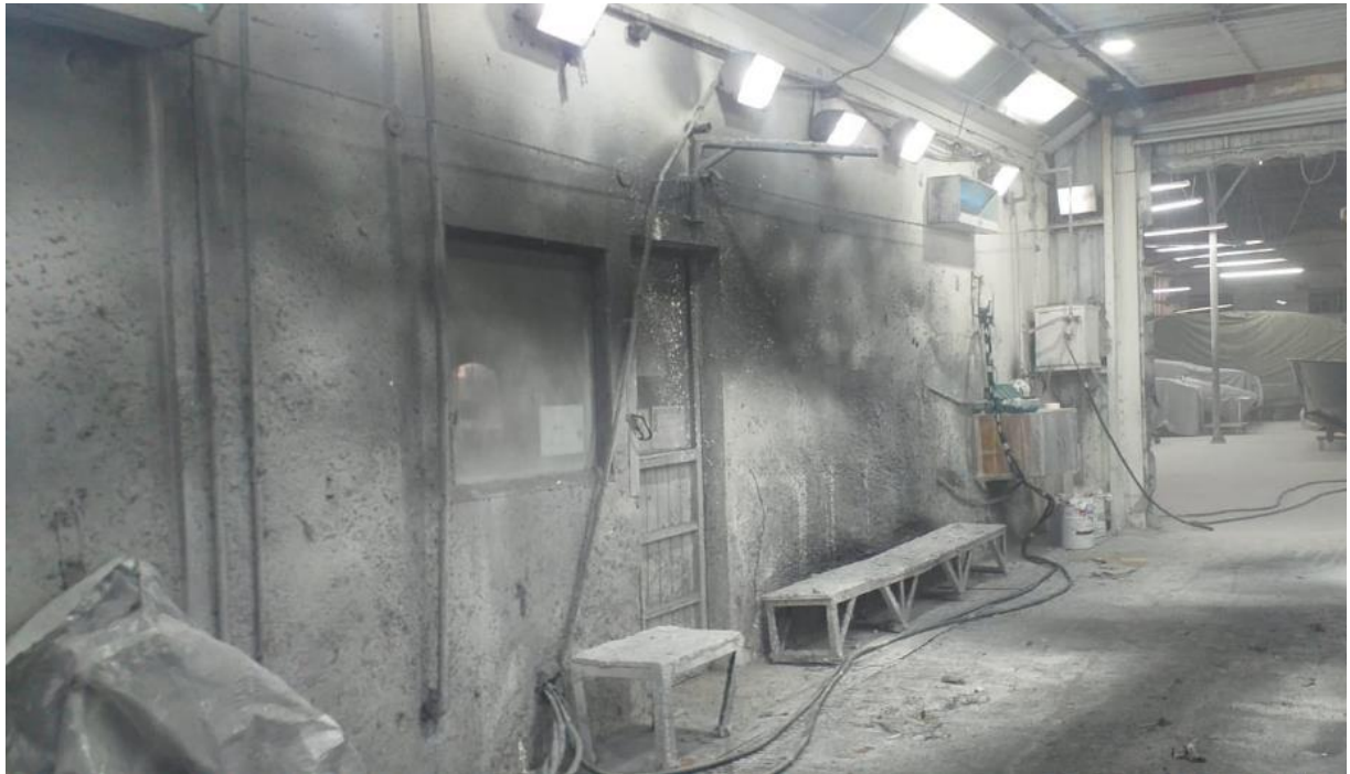
Figura 16 – Cabine de pintura antes da implementação do 5S
