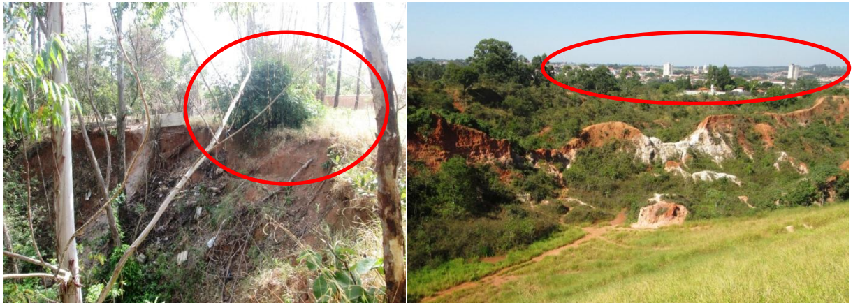
Figura 22. Áreas de ocorrência de voçorocas, danificando construções e muito próximas à área urbana.
