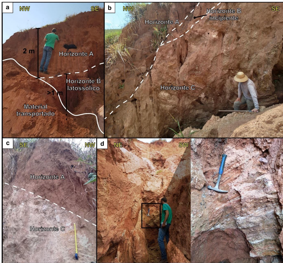
Figura 30 - Horizontes do solo nas paredes das voçorocas: (a) parede lateral norte da porção superior da voçoroca 1; (b) parede lateral norte da porção intermediária da voçoroca 2; (c) parede lateral sul da porção inferior da voçoroca 2; e (d) parede superior (cabeceira) da voçoroca 2, com destaque para o horizonte C, apresentando forte heterogeneidade devido à foliação herdada da rocha de origem.
