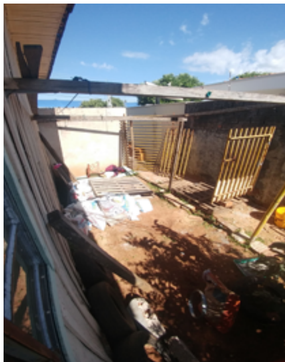
IMAGEM 47: Reconstrução do portão da Casassa, 2019.
