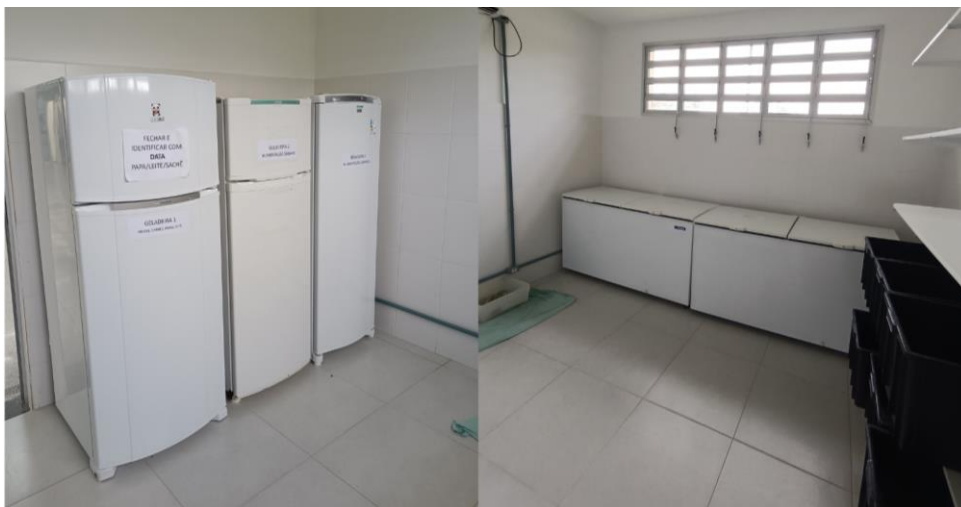
Figura 14. Sala refrigerada do CEMPAS em diferentes ângulos.
