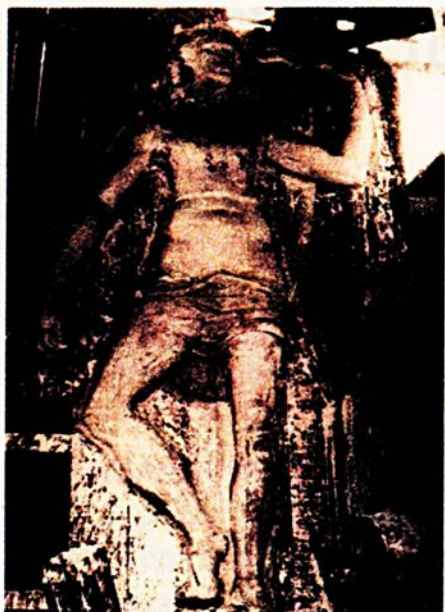
Figura da dança (ou teatro) em sua estrutura de concreto, antes de receber o revestimento colorido.
