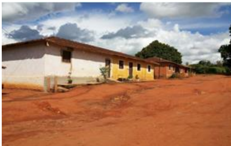
Figura 40 – Colônias em que moram diversas famílias no bairro Água Fria
