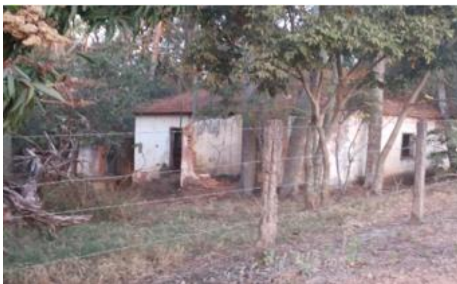
Figura 49 – Residências abandonadas no bairro Sítio Novo
