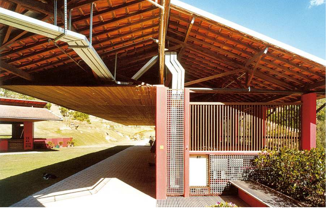
Figura 72 e 73 - Técnicas utilizadas no forro, Centro Hípico Polana
