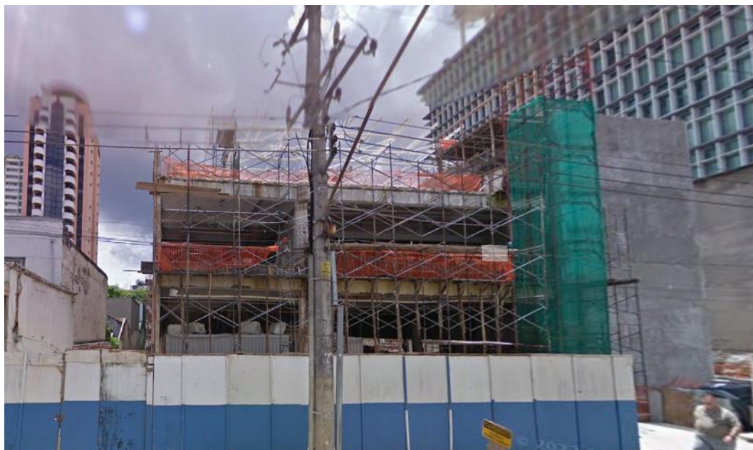
Figura 29: Construção da ampliação do CRC- 2010
