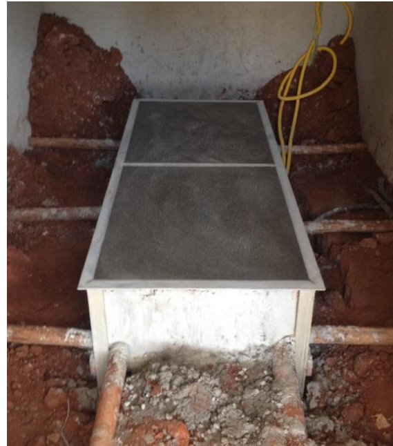
Figura 7 - Base inercial após concretagem.
