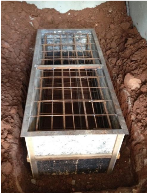
Figura 6 - Estrutura da base inercial.
