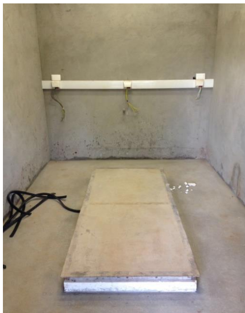
Figura 8 - Base inercial e contrapiso finalizados.
