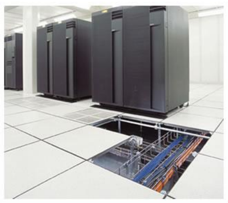
Figura 62 – Piso Elevado e Instalações.
