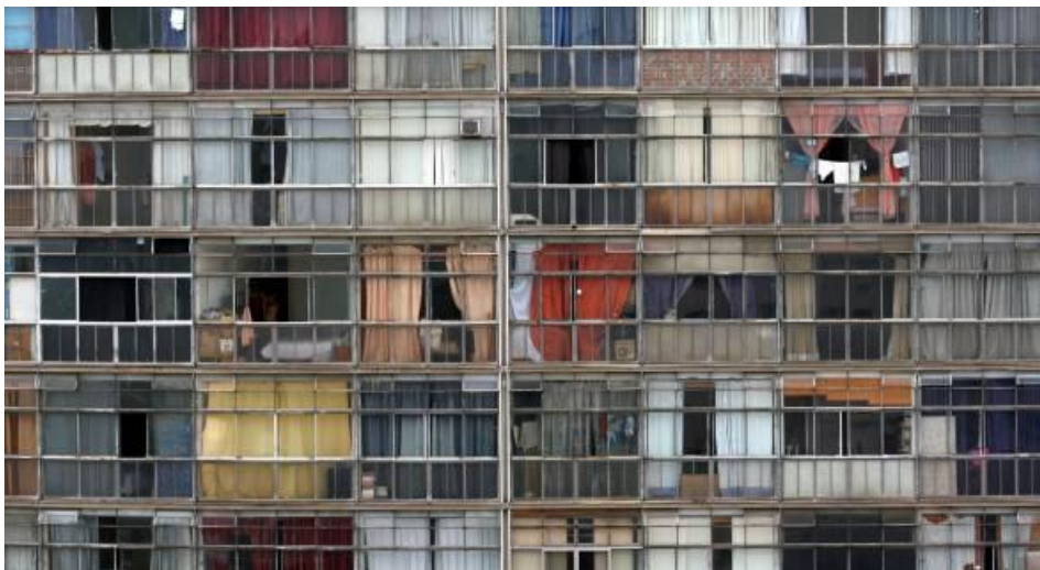
Figura 16 - COPAN, Fachada Oposta - Fonte: Google imagens.
