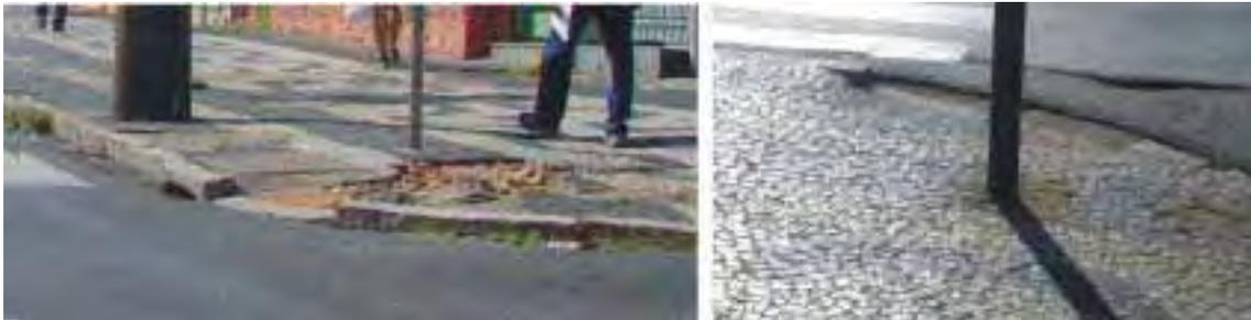
figura 51 – situação lamentável de algumas rampas de acesso para deficientes
