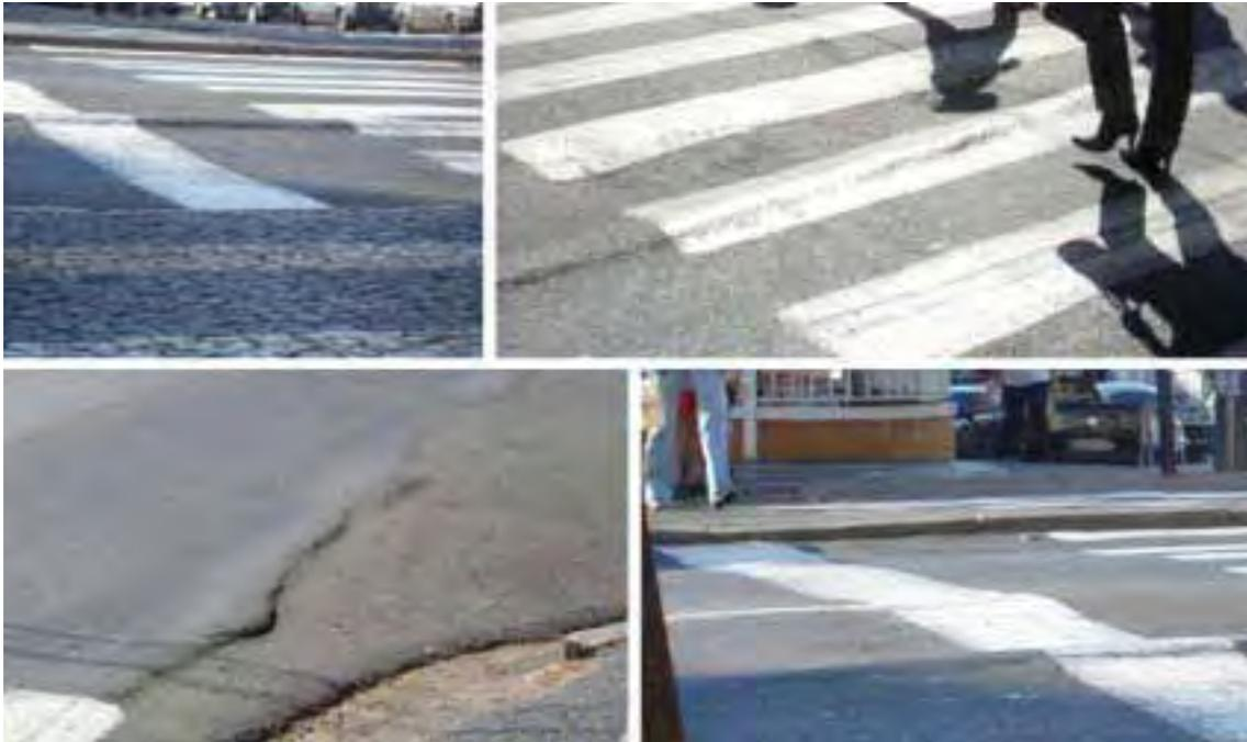
figura 49 – deformidades no asfalto da Av. Rodrigues Alves
