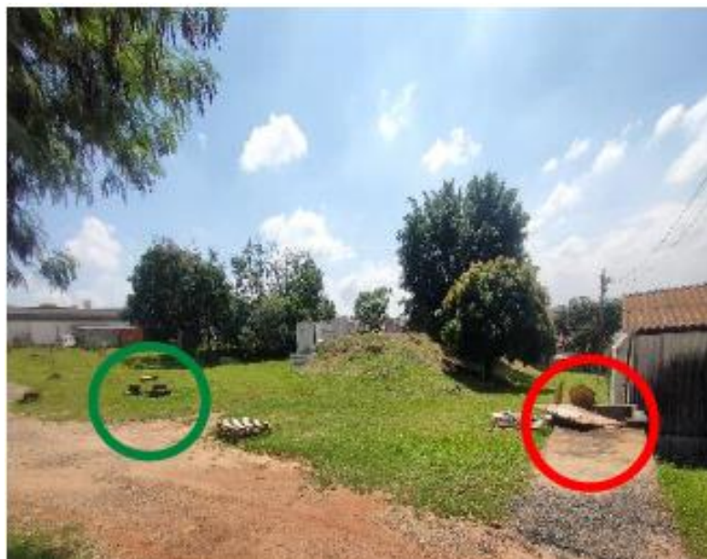
Figura 16- Destacado em vermelho – Entrada do tratamento industrial. Destacado em verde – Tubulação pluvial em que foi conectada a tubulação vinda do “Bota fora”
