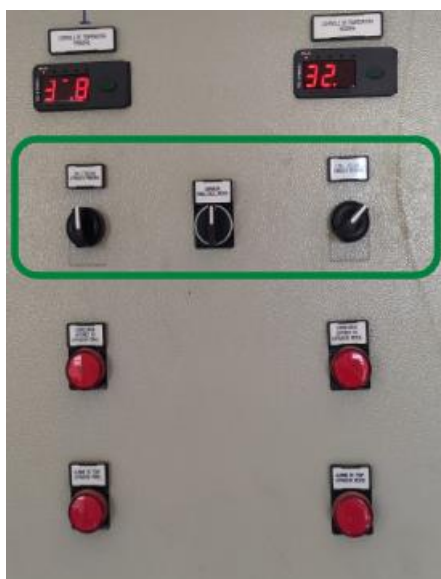
Figura 6- Chaves novas para ligar e desligar os sopradores do tratamento biológico
