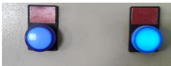
Figura 5- Botões antigos para ligar e desligar os sopradores do tratamento biológico.
