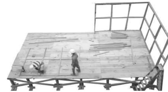
2- Adição do piso e das estruturas de vedação.
