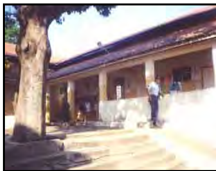
Figura 12: Situação da Escola antes da realização do projeto.
