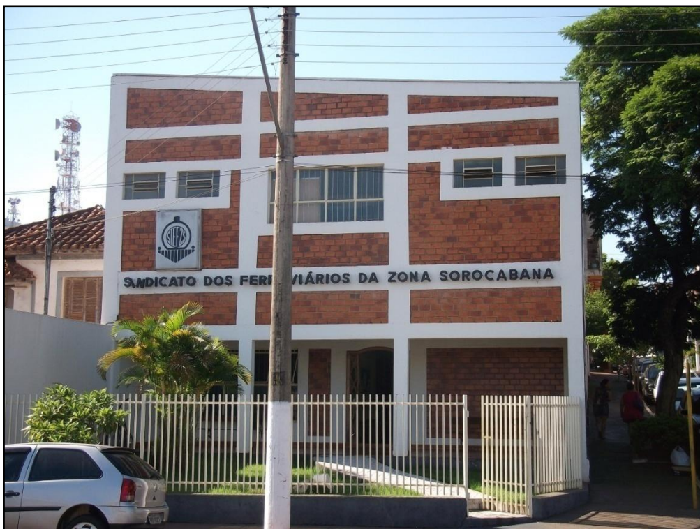
Figura 5: Sede do STEFZS em Ourinhos. Fonte: autor, 2012.
