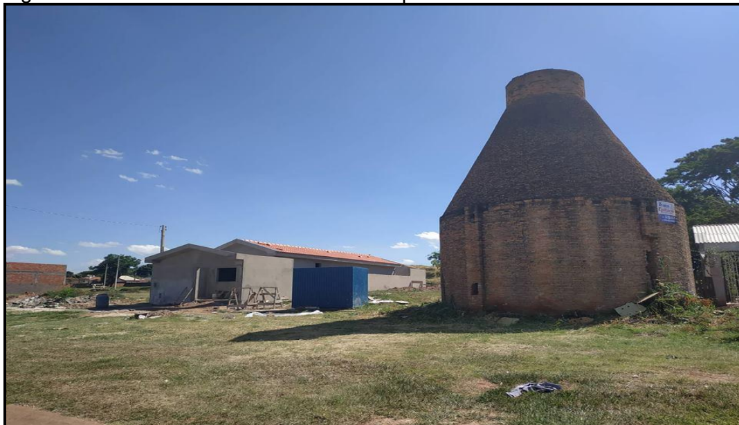
Figura 23- Forno na área urbana do município.
