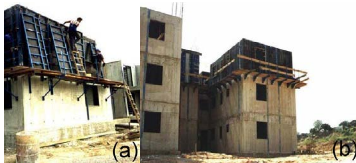
Figura 3 - Edifício executado em concreto celular (paredes estruturais).
