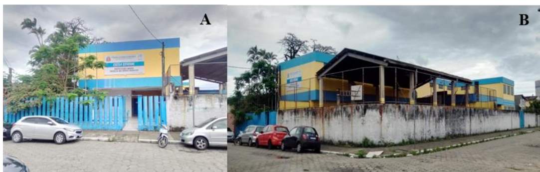
Figura 2 - Escola Estadual (A) vista frontal e (B) vista lateral.
