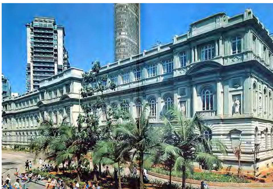
Figura 13 - Edifício de 1894 restaurado, localizado na Praça da República (centro da capital), atualmente sede da SEE de São Paulo.
