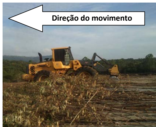
Figura 8: Atividade parcial desgalhar.
