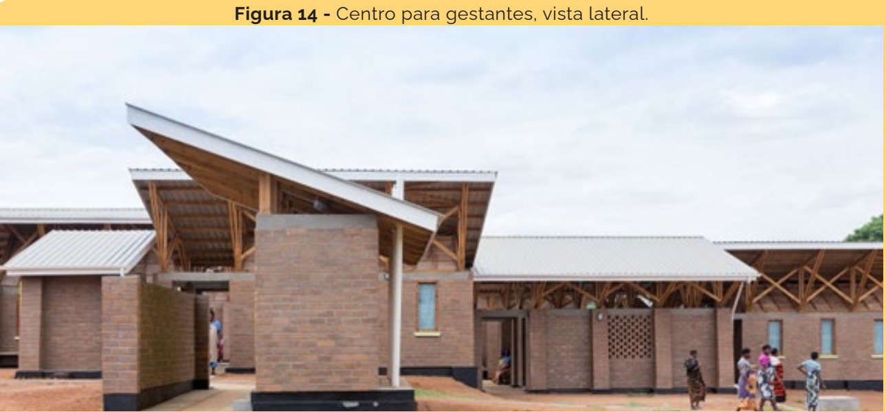
Figura 14 - Centro para gestantes, vista lateral.
