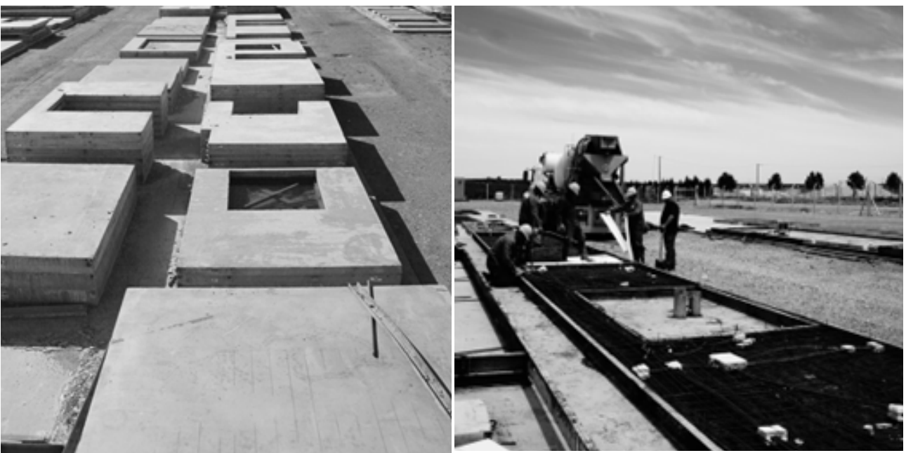
Figuras 18 e 19 - Elementos construtivos modulares e execução da fundação.
