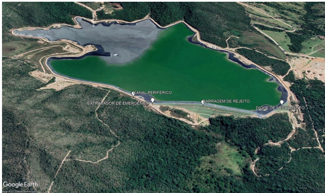
Figura 23 - Vista geral da barragem de rejeitos.
