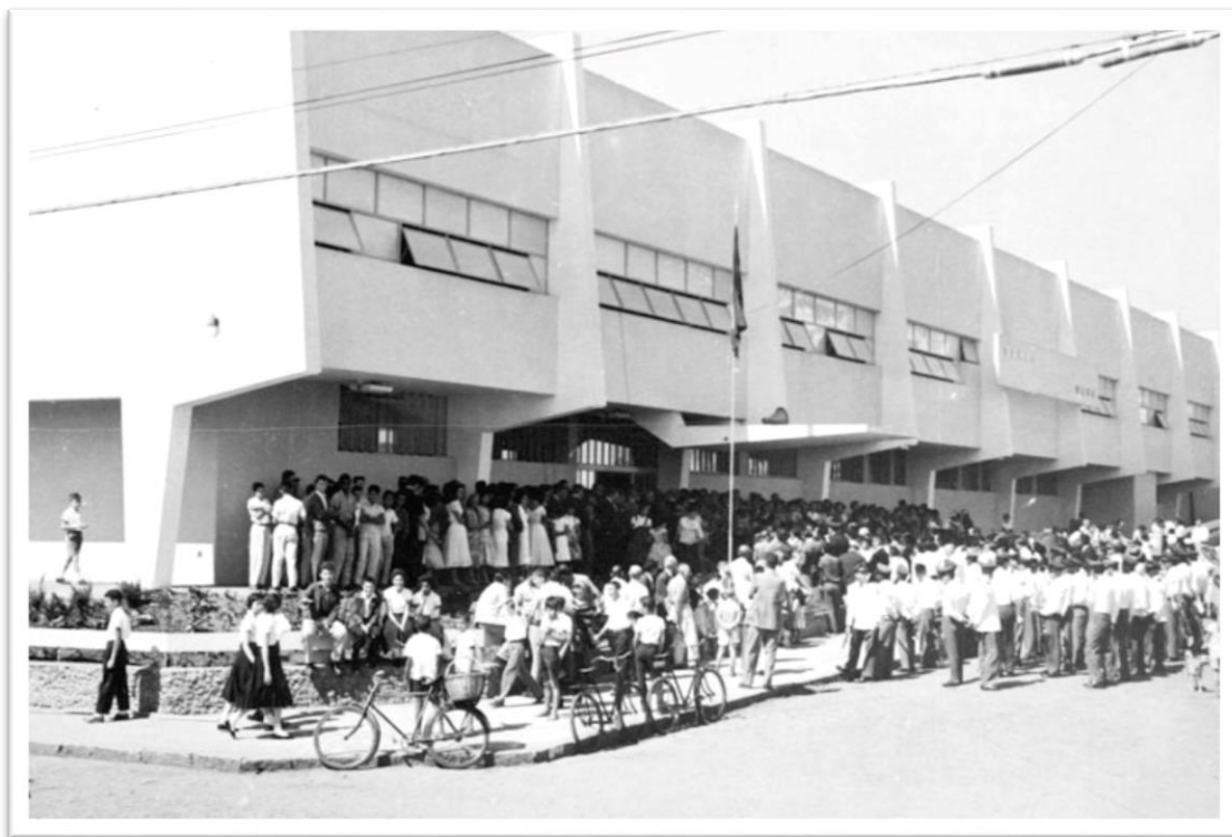
Figura 32 – Prédio SENAC em Bauru – Entrada principal situada na Rua Sant’ Martin n. 10-22
