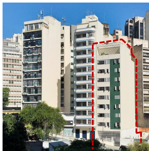
Figura 43 – Fachada nova do Edifício Asdrúbal do Nascimento II
