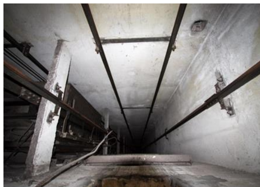
Figura 31 – Foço dos elevadores
