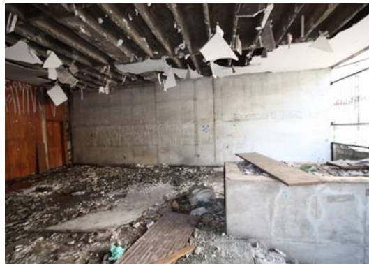
Figura 25 – Muro de mármore com pixo
