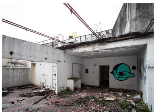
Figura 33 – Acesso a cobertura
