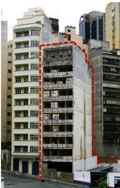
Figura 23 – Estado de degradação do edifício Asdrúbal do Nascimento II antes da reabilitação e integração ao programa habitacional
