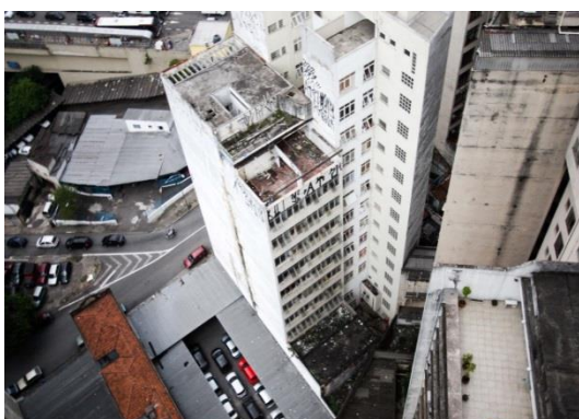
Figura 34 – Vista área do prédio
