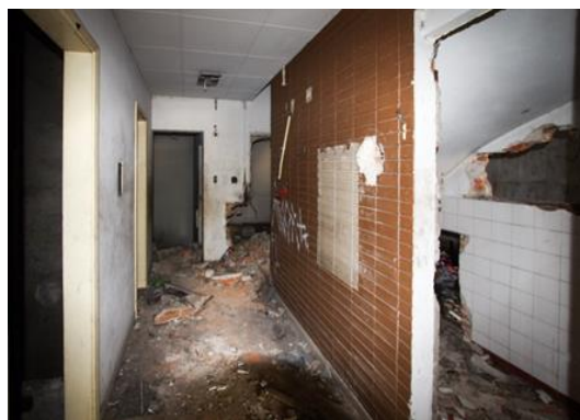
Figura 29 – Corredor dos elevadores
