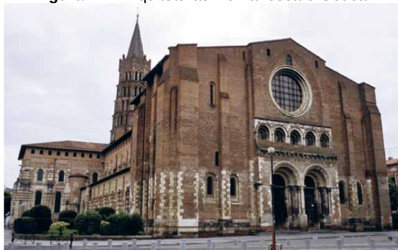
(A) Basílica de Saint-Sernin, na França – Arquitetura Românica com ênfase na horizontal e arco redondo.
