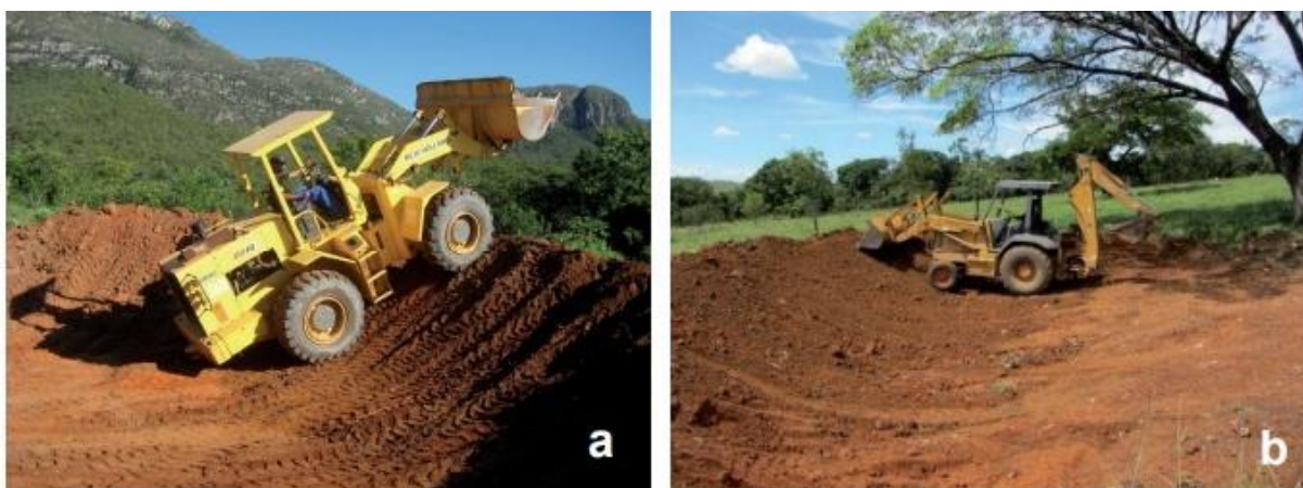
Figura 1. Barraginha em construção utilizando pá-carregadeira (a) ou retroescavadeira(b)
