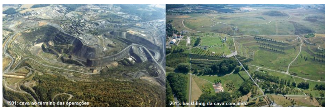
Figura 18: Operação de preenchimento em antiga cava de urânio
