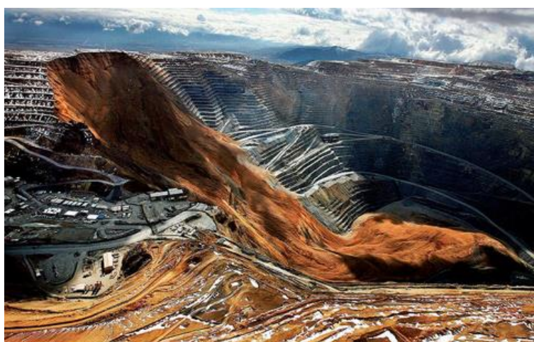
Figura 3: Exemplo de ruptura circular ocorrida em Utah/USA
