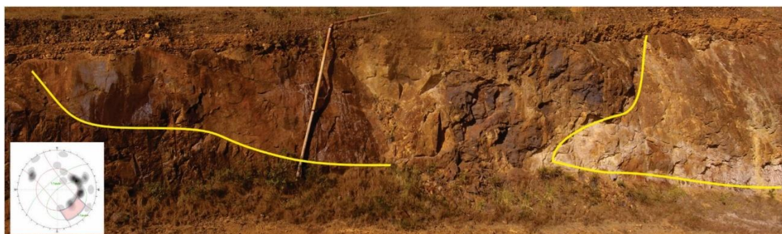
Figura 59: Rupturas do tipo planar visíveis na face do talude
