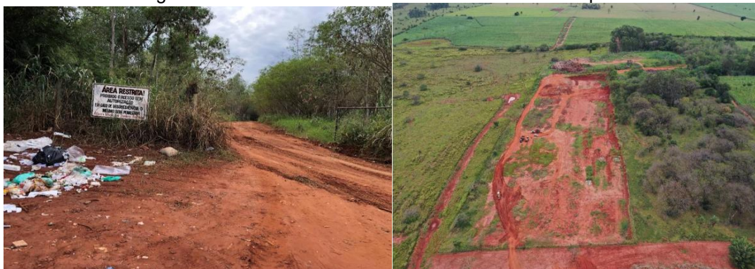
Figura 15 - Aterro sanitário em valas de Teodoro Sampaio
