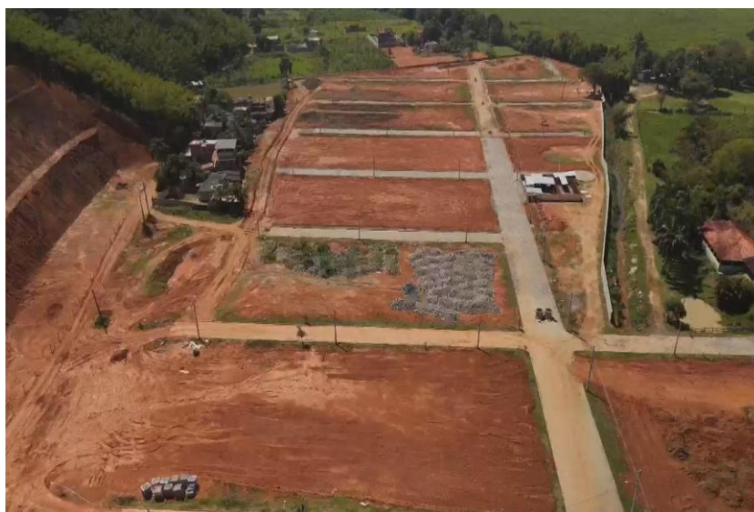
Figura 25 – Implantação de loteamento irregular em área rural de Magé: terraplanagem, abertura de vias e parcelamento do solo
