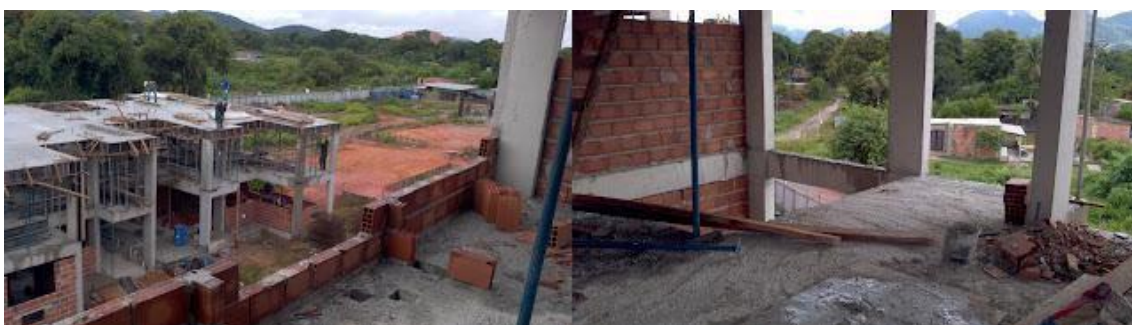
Figura 10 – Obras em andamento sobre antiga área de produção agrícola em distrito rural de Magé
